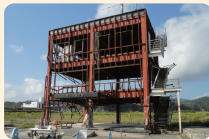
被害の大きさを物語る防災対策庁舎(平成26年9月28日宮城県南三陸町)
