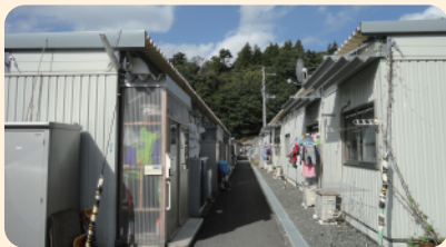
最大4畳半2間2DKの仮設団地(平成26年9月27日岩手県釜石市)
