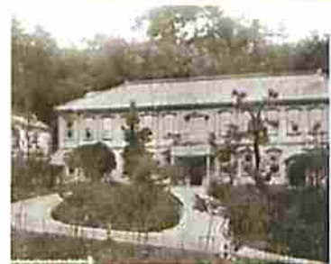
市庁舎(初代)の写真。現在の市庁舎は、小川町の国道16号線沿いがありますが、当初は諏訪町(現在の緑が丘・聖ヨゼフ病院の地)にありました。
